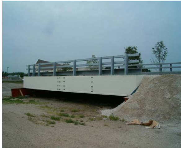
(d) Barrier rail installed
